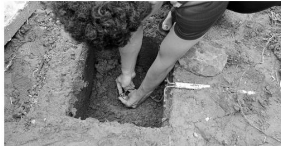
Gambar 9. Proses Pembuatan Sistem Pembumian untuk PLTS
