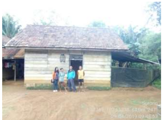
Gambar 3. Rumah tidak layak huni Sumber : BSPS Kabupaten Tebo (2019)
