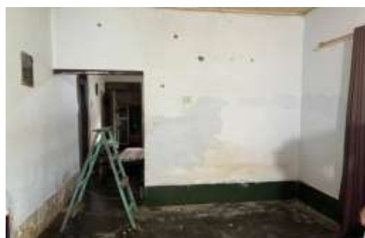
Gambar 10: Kondisi rumah Mitra sebelum direnovasi.
