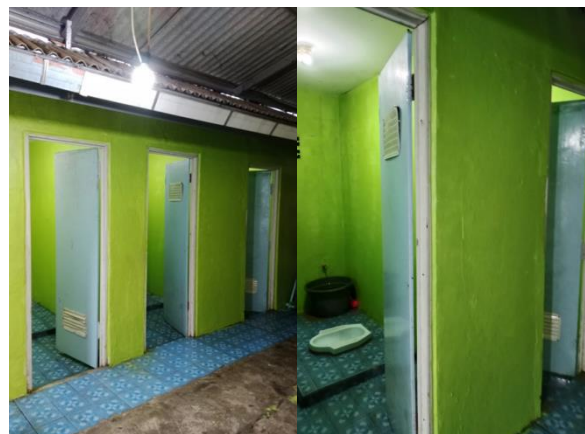
Gambar 4. Kondisi Kamar Mandi Setelah Proses Renovasi Sumber: dokumentasi penulis
